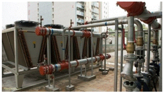
图 7：屋顶摆放的水冷散热系统，为室内芯片散热，矿主透露每个月支付电费达到约 5 万美元
